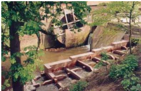
Рис.3. Басейновий рибохід, збудований із клінкерної цегли, з чергуванням басейнів, розташований біля млинової греблі у місті Гуде на річці Берне (Нижня Саксонія). Конструкція гармонійно вписується в історичний вигляд старого млина.
