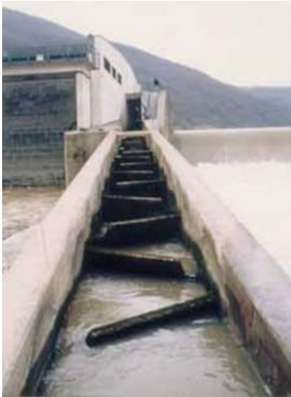
Рис. 6. Приклад ромбового рибоходу (водозлив Лемген на річці Мозель, вигляд з нижнього б'єфа)
